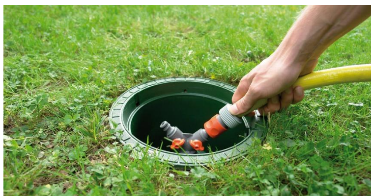
Abb. 4.1.4.10) Externe Wassersteckdose mit Gardena-Anschlüssen
