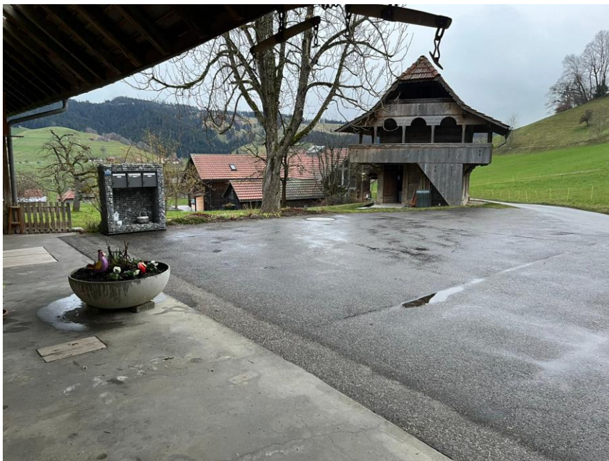
Abb. 4.1.1.1) Der Vorplatz unter dem sich die Güllegrube befindet.
