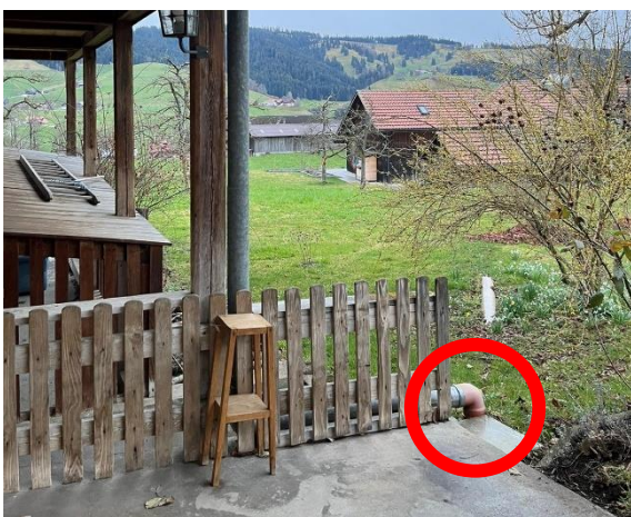
Abb. 4.1.1.2) Das Rohr vom Dach herunterführt
