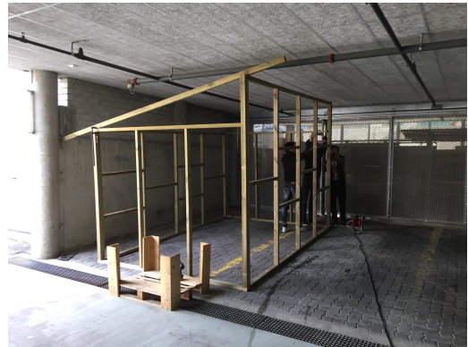
1 premier montage de la serre
