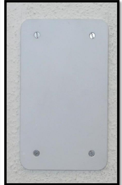
Fertige Abdeckplatte montiert und geerdet
