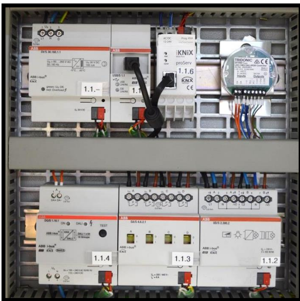
KNX-Steuerung + Netzwerk
