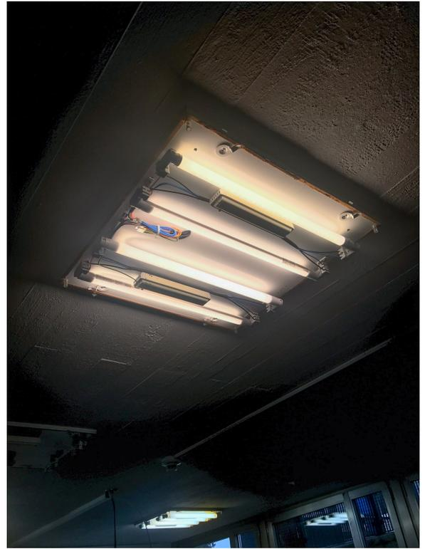
Abbildung 2: neue LED Lampen (7.6Watt)
