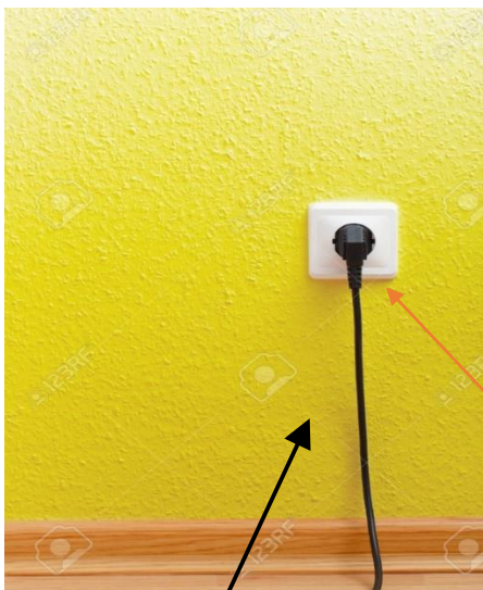
Figura 3: Presa elettrica con cavo di collegamento
