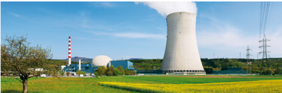
Abb. Kernkraftwerk Gösgen 2
