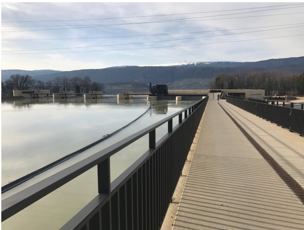
Abb.2.9 Neues Kraftwerk in Hagneck
