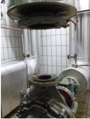
Nachdem der Motor vom Stromnetz abgehängt wurde, musste der Flansch zwischen Wasserpumpe und Wasserleitung gekappt werden, so konnte man den Motor später abtransportieren.
