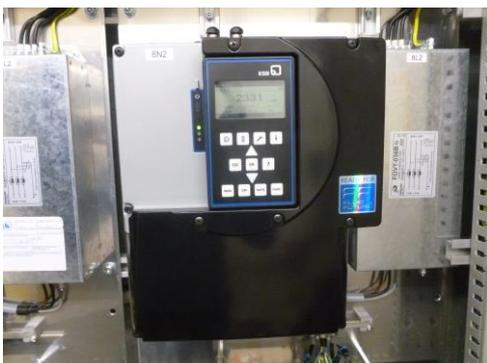
Nachdem alle mechanischen Schritte vollbracht waren, folgte nun noch die Elektronik. Diese konnte wieder durch einen internen Elektriker durchgeführt werden, was zusätzlich Geld sparte. Das alte Steuerungsgerät wurde entfernt und durch ein neues, auf die Motoren passendes ersetzt. Auf dem Display kann man den Energieverbrauch ablesen und den Stromzufuhr auf die Motoren regeln.
