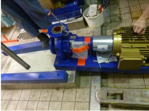
Der nächste Schritt war es, die neue Wasserpumpe auf die bereits fixierten Stahlträger zu montieren. Um dies zu vollbringen, benutzte man erneut einen Kettenzug, welcher von der Decke aus die Pumpe in die entsprechende Position brachte.
