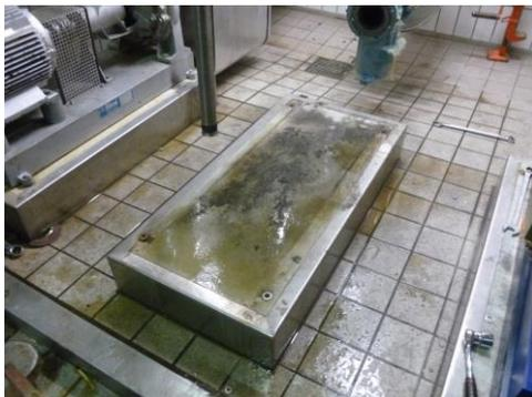
Nachdem die Wasserpumpe abtransportiert wurde, konnte man das alte Podest reinigen und auf die neue Pumpe vorbereiten. Das Podest musste möglichst sauber sein, damit die neue Einheit schön auf dem Podest aufliegt.
