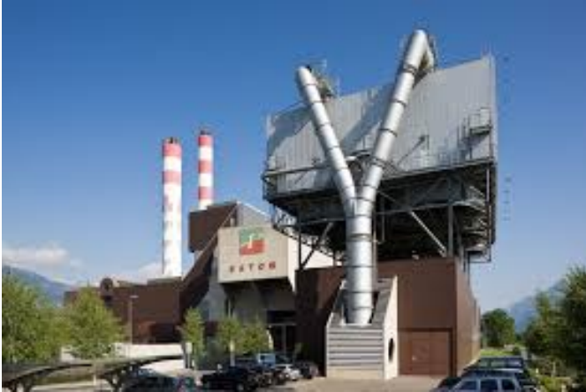
Photo de l'usine d'incinération de déchets ménagers « SATOM » de Monthey.
