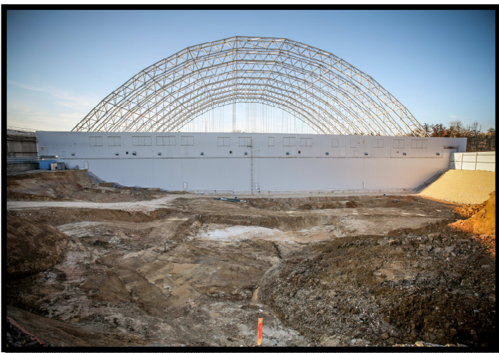
Vue de l'assainissement de la décharge de Bonfol
