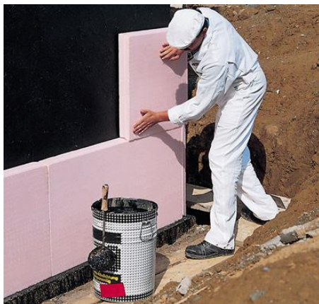
Abb. 7: korrekte Verbauung (daemen- und sanieren, 2012)
