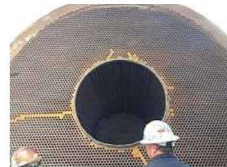
Abbildung 28: Rohrbündel-Wärmetauscher
