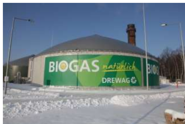
Abbildung 19: Biogasanlage von Aussen
