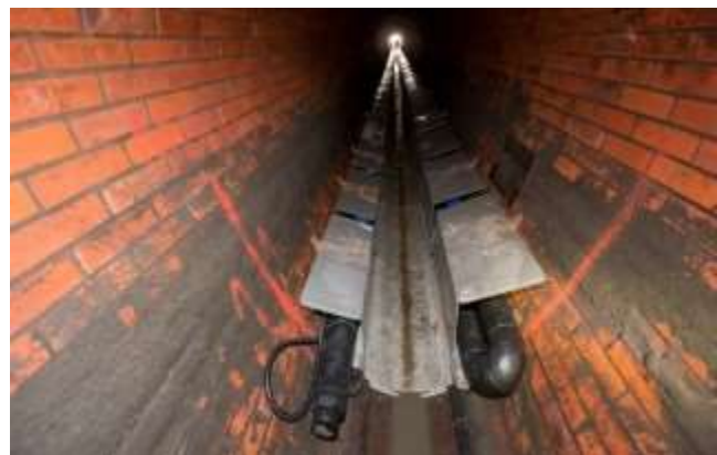
Abbildung 17: Rohreinlegung in Kanalisationsnetz
