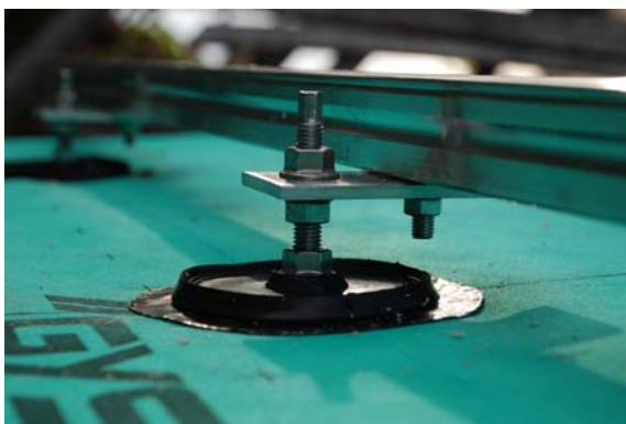
Abbildung 5: Montage der Halterungsschienen (Quelle: Eigenes Bild)
