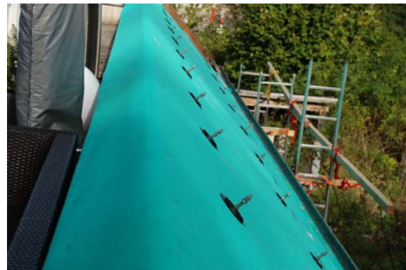
Abbildung 4: Montage der Halterungen: Eigenes Bild)
