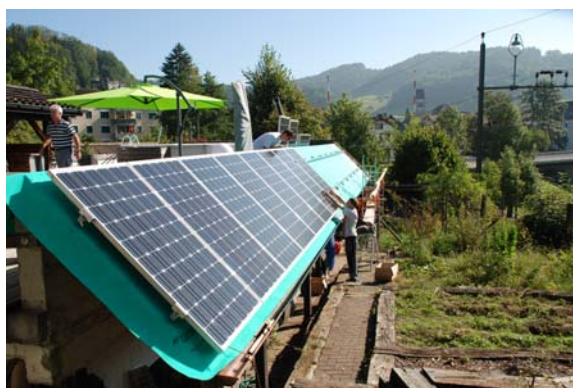
Abbildung 11: Befestigung der einzelnen Panels (Quelle: Eigenes Bild)
