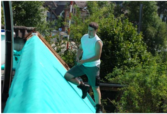
Abbildung 3: Befestigung der Unterdachfolie (Quelle: Eigenes Bild)
