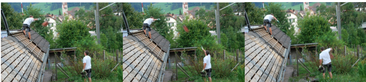
Abbildung 2: Dachabdecken für die Montage der PV (Quelle: Eigene Bilder)
