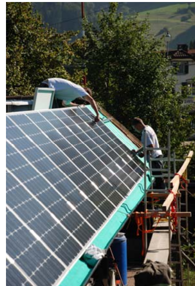
Abbildung 6: Montage der Panel (Quelle : Eigenes Bild)
