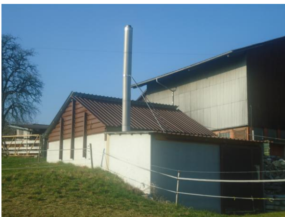
Abbildung 2 Holzsnitzelheizung Ansicht von Süden
