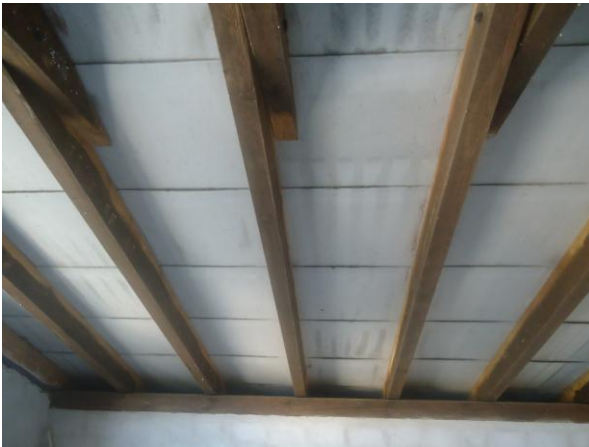
Abbildung 5 Dach innen ohne Isolation
