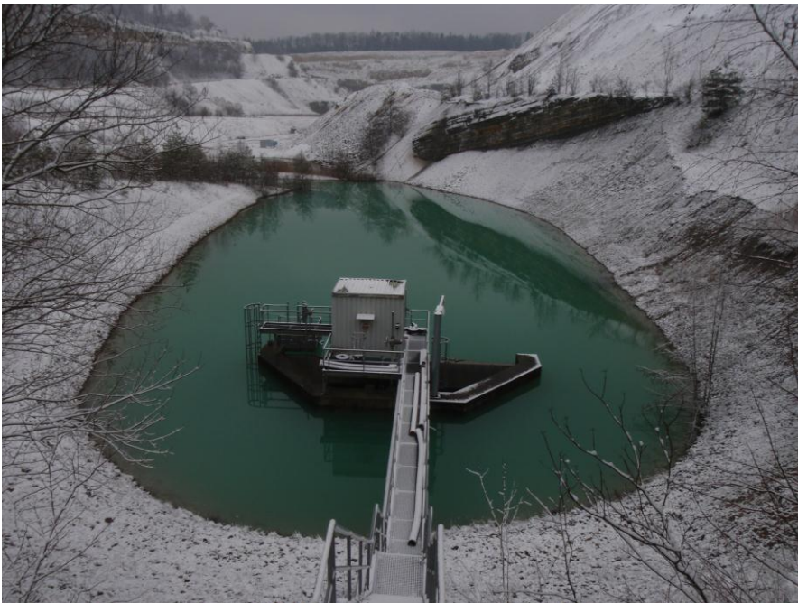
Bild 1: Absetzbecken im Steinbruch
